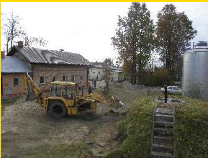
b) budowa wraz z przebudow SUW w m. Stare Lipki
