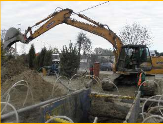
a) budowa kanalizacji w m. Stare Lipki
